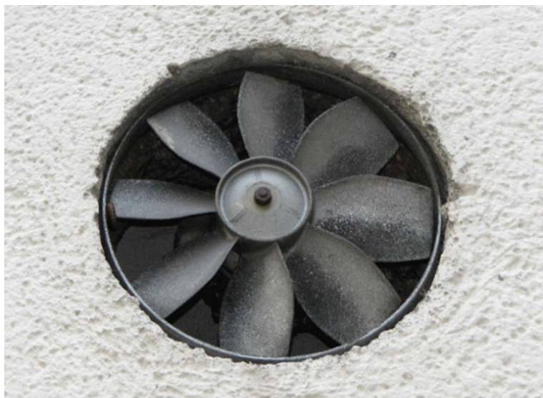
Figur 5: En enkel vifte og varmeveksler for utnyttelse av overskuddsvarmen kan være tilstrekkelig hos mindre produsenter
