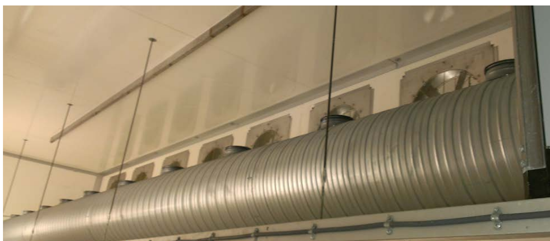
Figur 6: Ventilasjonsrør med flere åpninger kan være en mulighet til å distribuere oppvarmet uteluft i et større egnet lager for slutt-tørking (ikke med viftene bak).
